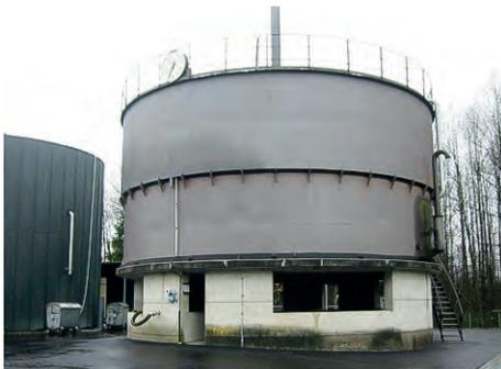
Das aus der Faulung entstehende Gas wird in einem Gasbehälter gespeichert. In einem Blockheizkraftwerk wird das Gas zu 1/3 in Strom und zu 2/3 in Wärme umgewandelt. Die maximale Gesamtleistung beträgt 115 KW. Die Wärme wird zum Aufheizen des Faulschlammes und der Betriebsräume verwendet. Der Strom deckt einen Großteil des Strombedarfs der Kläranlage ab.
