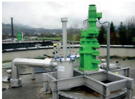
Im Faulturm wird der Schlamm ausgefault. Im Bild sind Motor und Getriebe für die Umwälzung sichtbar, mit dem der Schlamm umgerührt wird. Spezielle Dichtungen und Sicherheitseinrichtungen sorgen für einen gesicherten Betrieb.
