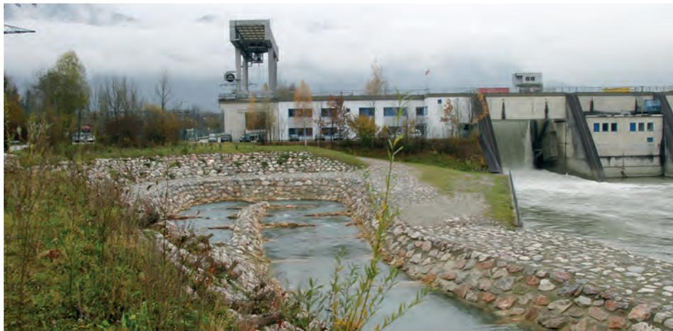
Die Fischaufstiegshilfe beim Innkraftwerk.
