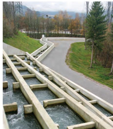
Die Fische und Wasserlebewesen können mit dieser Aufstiegshilfe die Barriere des Flusskraftwerkes leichter überwinden.
