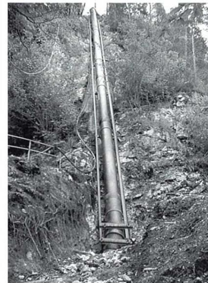
Parallel zur Druckrohrleitung wurde die Kanalleitung verlegt
