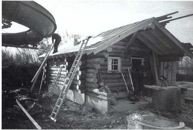
◀ Hinter der Großwasserrutsche wurde eine original finnische „Kelosauna“ errichtet. Bei dieser beeindruckenden Gesamtkonstruktion wurde 300 Jahre altes finnisches Kiefernholz verarbeitet. Die Sauna ist für ca. 25 Personen ausgelegt.
