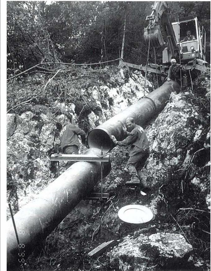
Eine besondere Herausforderung an die Bauarbeiter war die Verlegung der Druckrohrleitung am felsigen Aufstieg ins Kaisertal
