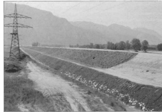
Sichtbar dem Ende zu gehen die Dammschütarbeiten im Kraftwerksbau. Durch die bereits druchgeführten Begrünungs- und Bepflanzungsmaßnahmen hat der Damm größtenteils seine Wuchtigkeit verloren.
