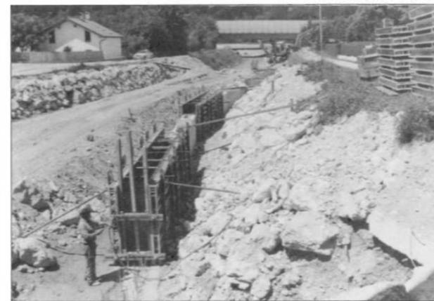
Die Arbeiten konzentrieren sich nun überwiegend auf die Erstellung des Dammes von der Schanz flußaufwärts und den Ausbau des Sparchenbaches sowie die planmäßige Fertigstellung des Krafthauses mit seinen riesigen Wehranlagen: Hier der entstehende Schotterfang im Bereich Kaiserbach-Waldeck.
