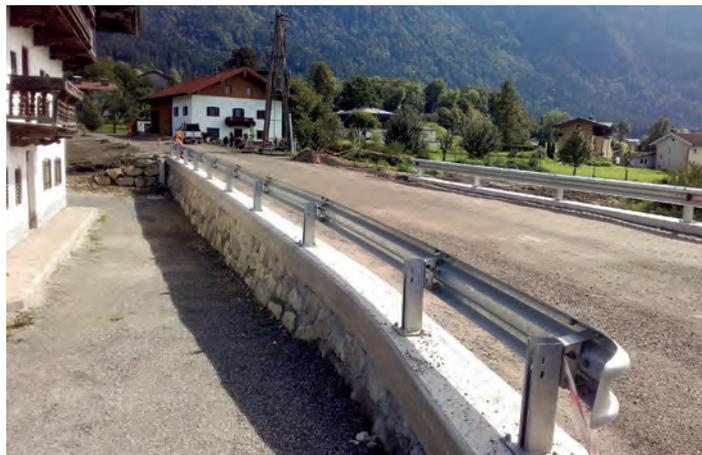
Die bestehenden Stützmauern wurden abgetragen und eine Steinschichtung mit aufgesetzter Leitschiene errichtet.
