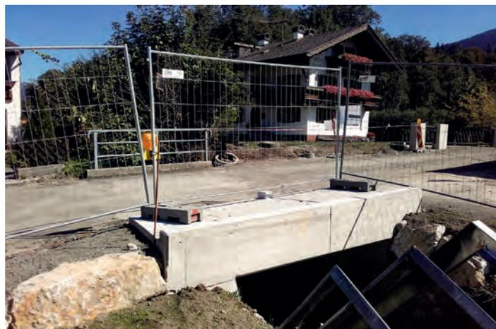
Im Zuge der Sanierung der Kaiserbergstraße im Bereich Lobacher Bühel wurde der 2. Bauabschnitt begonnen. Teil dieses Bauabschnittes ist die Anpassung der Straßenentwässerung, eine Verbreiterung der Straße im gesamten Verlauf und die Errichtung eines breiten Gehsteiges. Im Bereich der Hofstellen Lengauer und Schmolch wurden Steinschichtungen errichtet. Die Brücke über den Heubach wurde für die Errichtung des Gehsteiges deutlich verbreitert.
