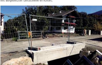
Im Zuge der Sanierung der Kaiserbergstraße im Bereich Lobacher Bühel wurde der 2. Bauabschnitt begonnen. Teil dieses Bauabschnittes ist die Anpassung der Straßenentwässerung, eine Verbreiterung der Straße im gesamten Verlauf und die Errichtung eines breiten Gehsteiges.
