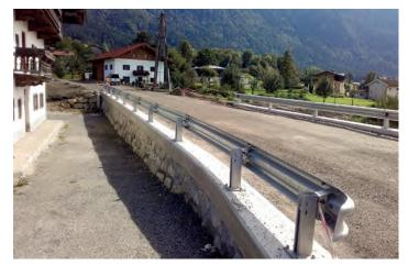
Die bestehenden Stützmauern wurden abgetragen und eine Steinschlichtung mit aufgesetzter Leitschiene errichtet.
