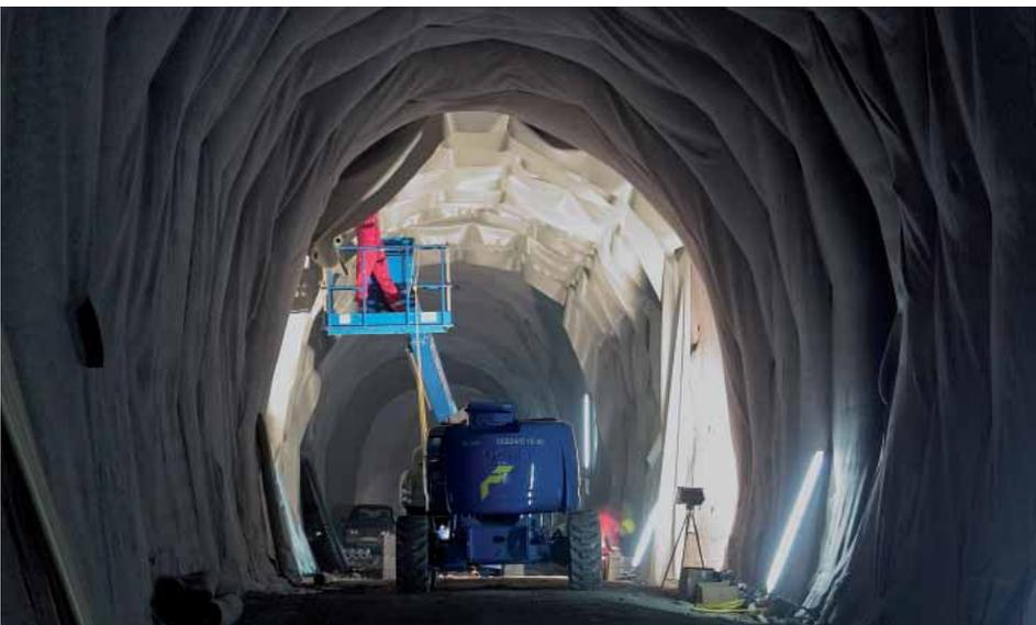
Die Feuchtigkeitsisolierung wird auf die Außenschale aufgedübelt.
