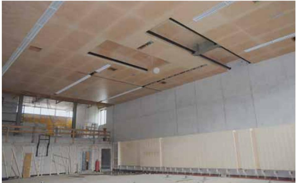
*Blick in die Sporthalle mit bereits montierter Holzdecke in Schallschutzausführung.*
