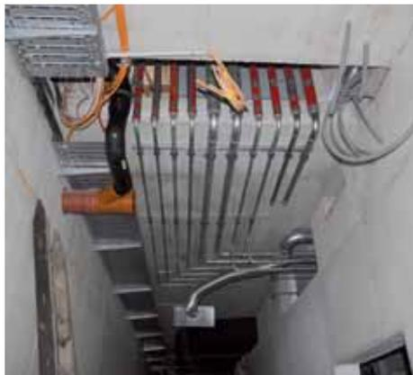
*In den Nassräumen und Gängen sind bereits die Installationen und Entlüftungssysteme angebracht.*
